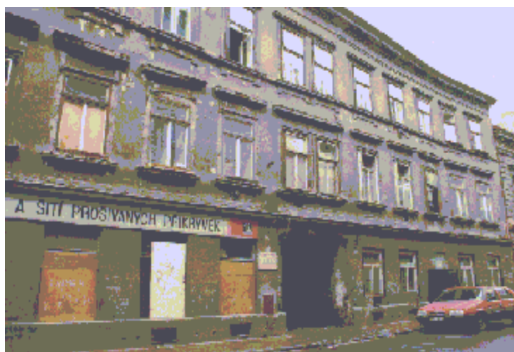
Uliční strana domu před rekonstrukcí.
