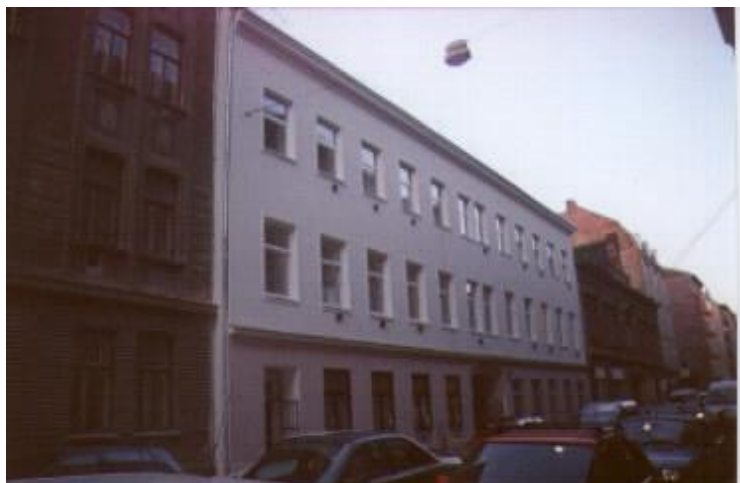
Středisko díky rekonstrukci domu v roce 2001 získalo nový kabát.
